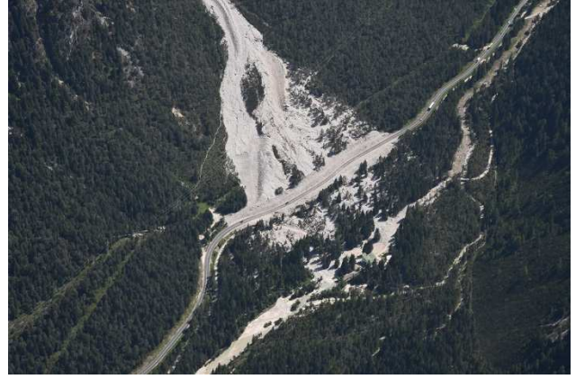
Figure 1. e 2. Colate detritiche dello Schadebach e del rio dei Baranci sull'abitato di Ferrara e sulla SS51 Alemagna.
