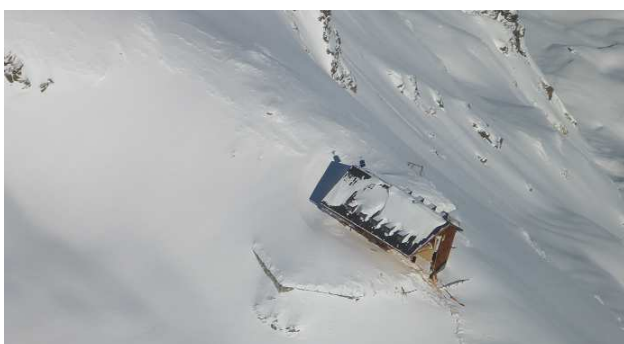
Abbildungen 9/10/11/12. Im Uhrzeigersinn vom Bild oben links: a) Unterbrechung der karnischen Staatsstraße Nr. 52 im Gemeindegebiet Sexten; b) Steinschlag auf den Freisingerhof in Rungg bei Tramin; c) Pilllawine im Gemeindegebiet Moos in Passeier; d) Von einer Lawine stark beschädigte Stettiner Hütte oberhalb des Pfelderer Tales.
