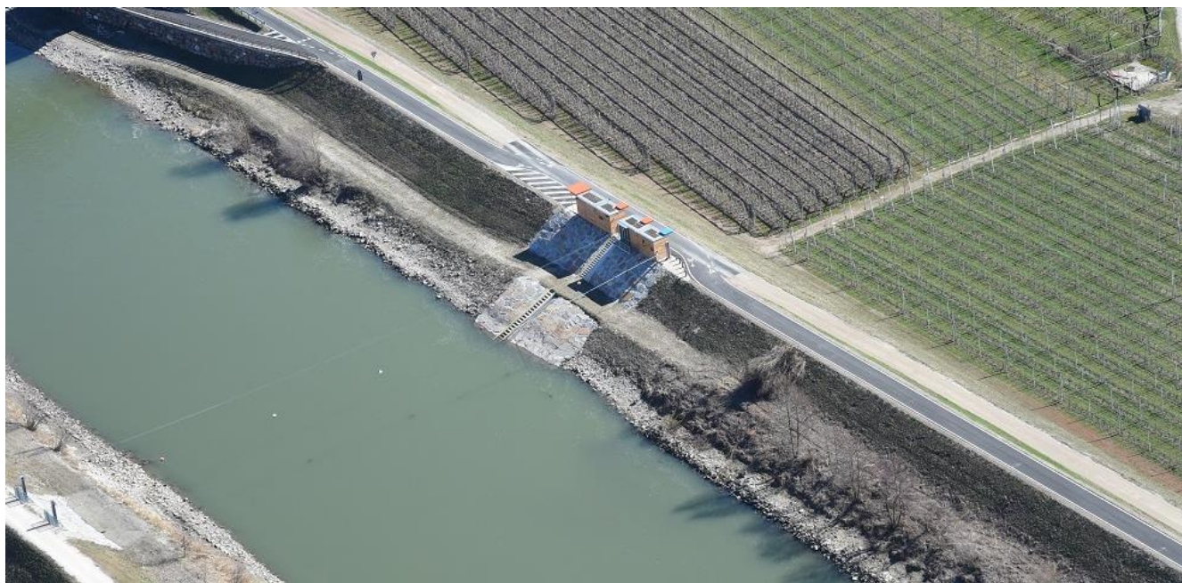
Abbildung 1. Luftaufnahme der neuen Pegelstation Etsch bei Salurn (14.03.2018, Luca Messina).
