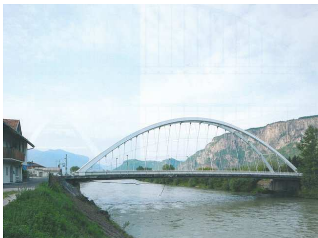
Abb. 1/2. Etschbrücke in Pfatten (erbaut 1997 - 2000) und alte Pfattner Brücke (1928) an neuem Standort
