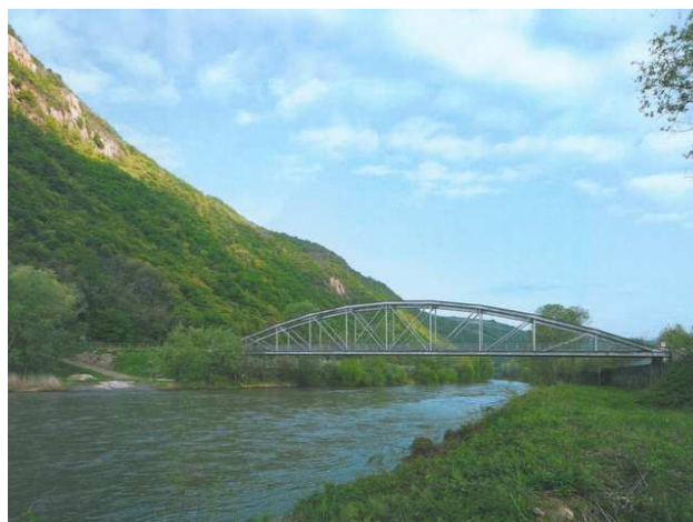
Fig. 1. e 2. Ponte sull'Adige a Vadena (costruito tra il 1997 ed il 2000) e vecchio ponte, risalente al 1928, dopo il suo riposizionamento.
