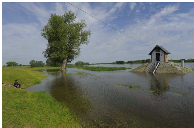
Figure 1./2. Idrometro di Ratzdorf nel Brandeburgo in corrispondenza della confluenza tra Oder e Neisse. Nell'immagine a sinistra in fase di piena crescente (20/05/2010), a destra al colmo di piena (28/05/2010).
