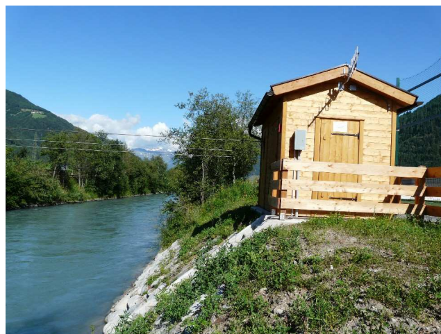
Abbildungen 1/2. Pegelstation am Eisack in Freienfeld, die als Bezugsmessstelle für das ober Eisacktal gilt.
