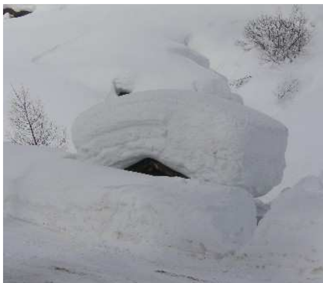
Figure 1/2. Stazione idrometrica rio Plan ad Eschbaum (12/02/2009) e cantiere per la costruzione di una nuova stazione idrometrica sul rio Gardena a Pontives (25/11/2008).
