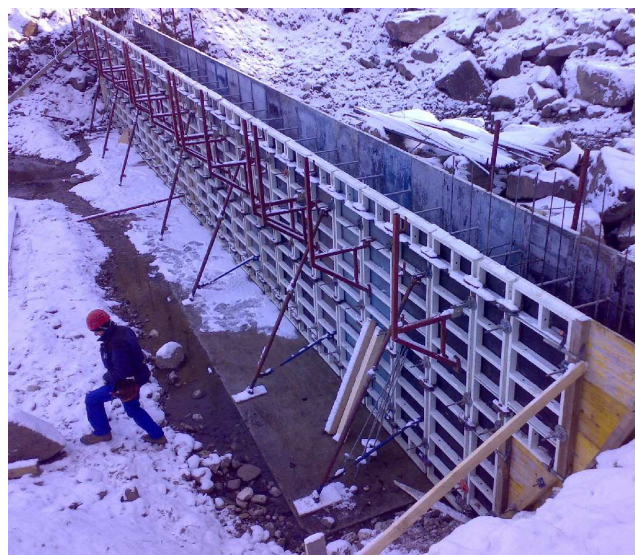
Abbildungen 1/2. Pegelstation am Pfeldererbach in Eschbaum (12/02/2009) und die Baustelle für die Errichtung des neuen Pegels am Grödnerbach in Pontives (25/11/2008).
